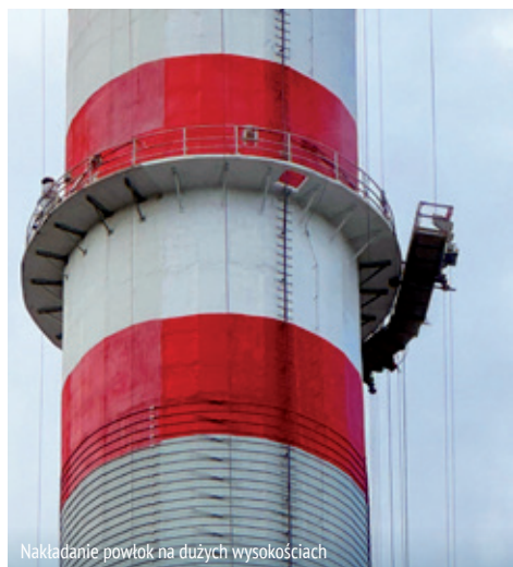
Nakładanie powłok na dużych wysokościach
