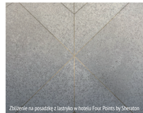
Zbliżenie na posadzkę z lastryko w hotelu Four Points by Sheraton
