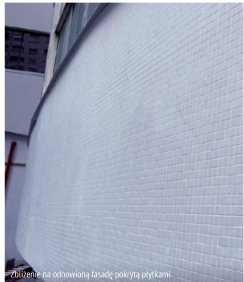
Zbliżenie na odnowioną fasadę pokrytą płytkami
