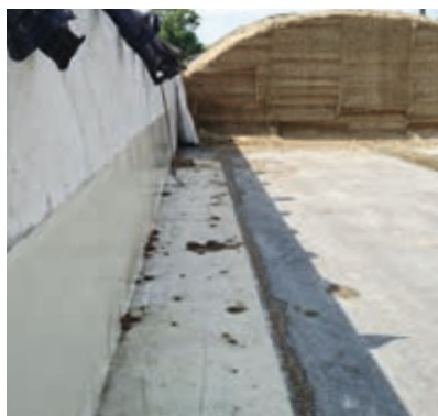
Ruchome układy silosów Kwaśny odciek kiszunkowy rozkłada beton w mobilnym silosie w bardzo krótkim czasie. MC-PowerPro HCR zapewnia trwałość.
