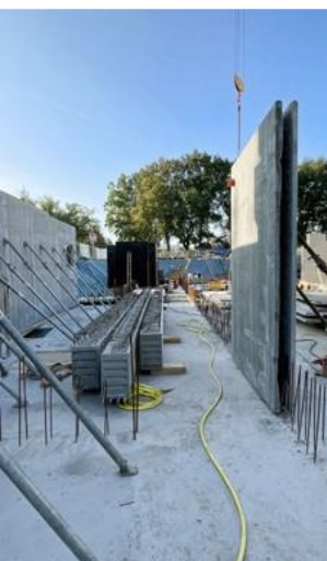
"Musterbude" firmy OTTO WULFF w Hamburgu jest wykonany z betonu z recyklingu, który częściowo zawiera kruszywa pochodzące w 100% z recyklingu, po raz pierwszy wykorzystane przy budowie szkoły w Hamburgu.
