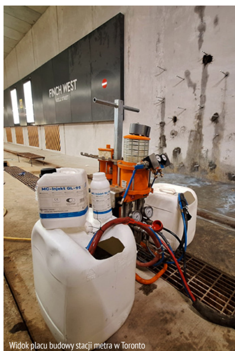
Widok placu budowy stacji metra w Toronto
