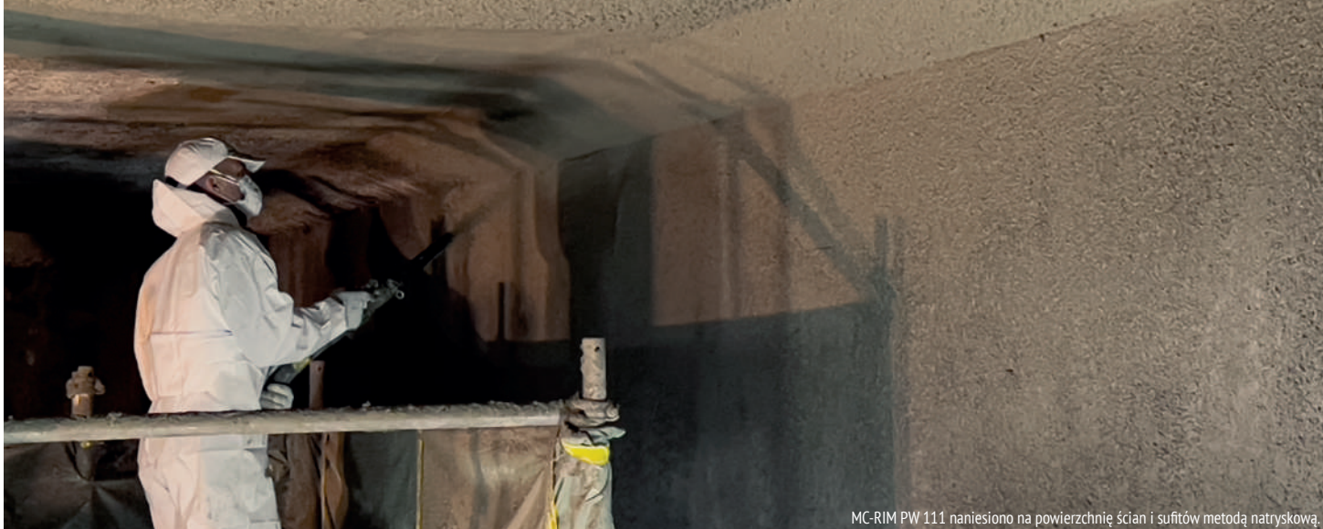
MC-RIM PW 111 naniesiono na powierzchnię ścian i sufitów metodą natryskową.
